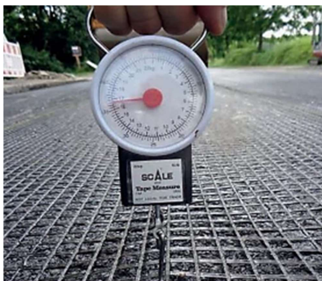
Obr. 6 Ukázka provádění zkoušky adheze výztužné mříže k povrchu vozovky
