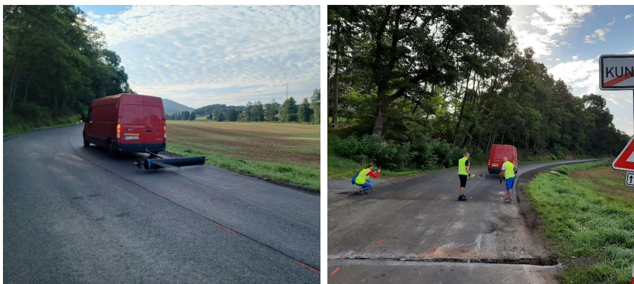
Obr. 7 Ukázka aplikace samoadhezní mříže TAV 1 SAM 1 s tahovou pevností 50 kN/bm
